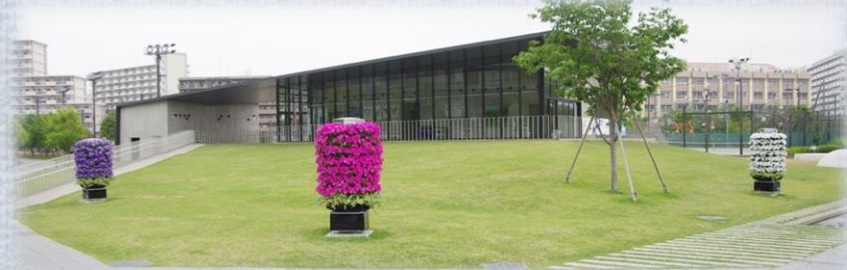
公園などの開けた空間に (葛飾にいじゅくみらい公園)
